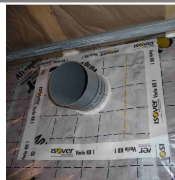
Détail d'étanchéité d'un conduit
