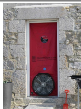
Porte du test d'infiltrométrie
