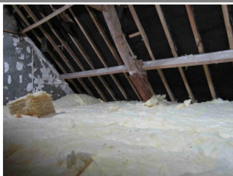
Isolation de 40cm des combles
