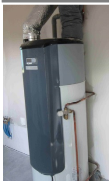
Ballon thermodynamique relié à la VMC
