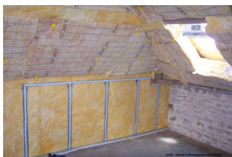
Isolation des rampants 08/2013
