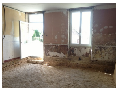
Décassement du sol pour drainer et isoler
