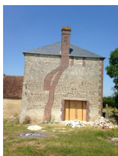
Création d'une ouverture pignon sud
