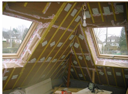
Isolation des rampants – 04/2013
