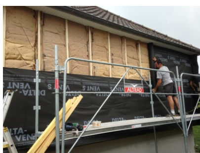
Mise en place de l'isolation thermique par l'extérieur
