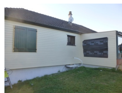
Surface vitrée après travaux
