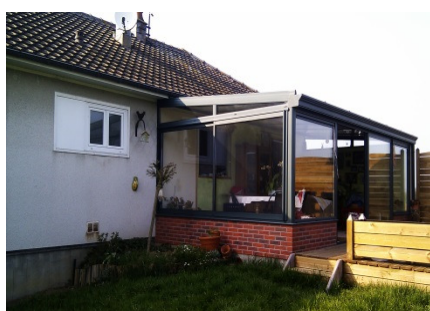
Surface vitrée avant travaux
