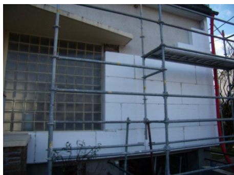
Isolation par l'extérieur - Janvier 2014
