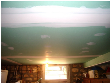
Isolation plafond du sous-sol - Janvier 2014
