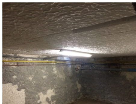
Isolation en sous face de la dalle entre le RDC et le sous-sol - Octobre 2014
