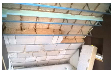
Isolation des combles
