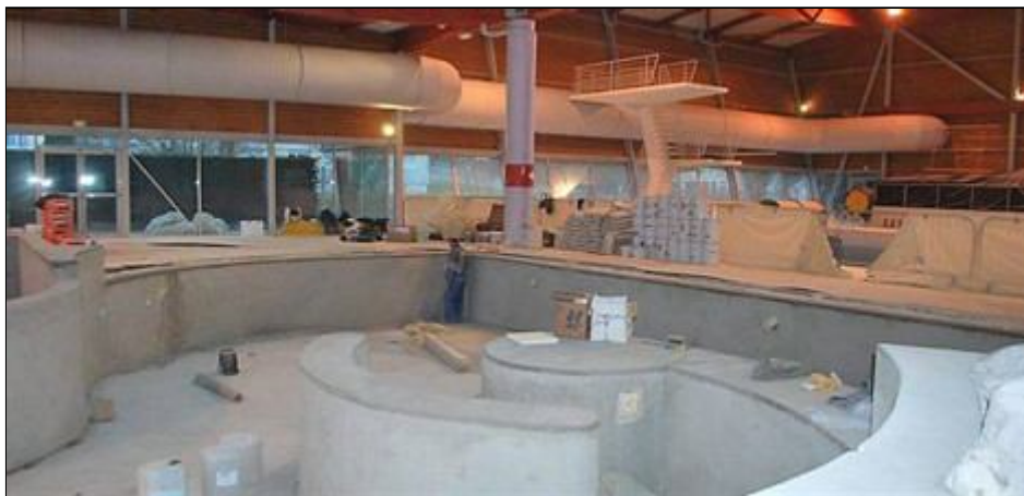
Grand consommateur d'énergie, le centre aquatique, actuellement en chantier pour y réaliser des économies, fera partie des équipements publics raccordé à ce réseau chaleur.
