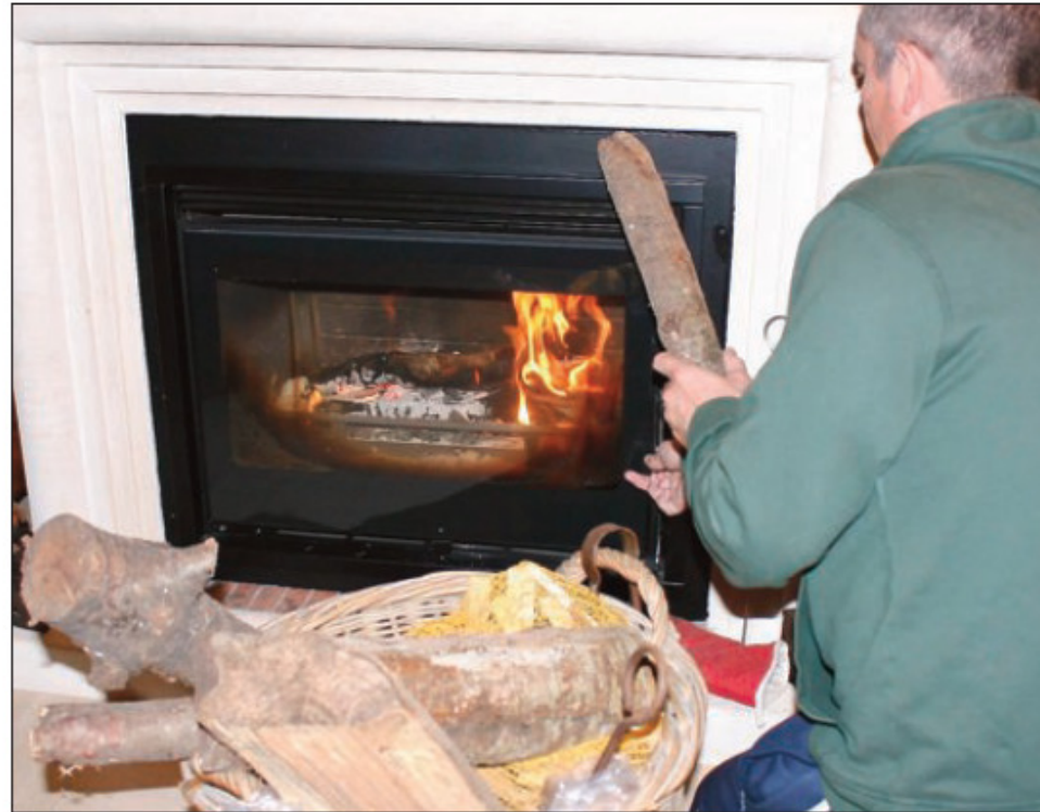
De la cheminée (ici, un foyer fermé avec insert) des particuliers aux chaufferies collectives ou industrielles, le bois est aujourd'hui une ressource énergétique en plein développement.
